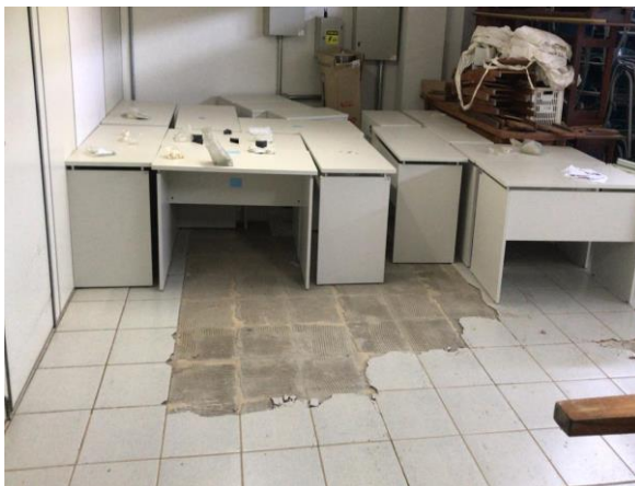
Figura 43: Condição dos revestimentos dos pisos do Almoarifado.
