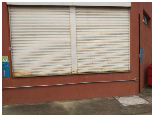
Figura 08: Janela da cantina dos Miniauditórios.
