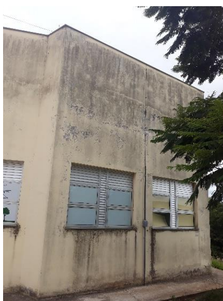
Figura 07: Condição da fachada externa dos Miniauditórios.
