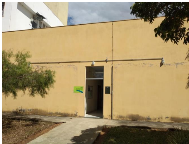
Figura 34: Fachada externa do prédio.
