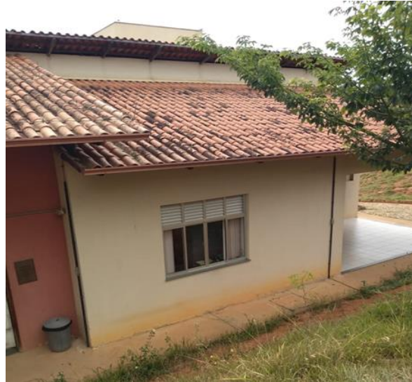
Figura 40: Situação do telhamento do prédio.
