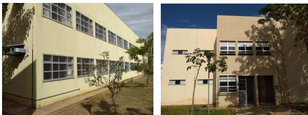
Figuras 12 e 13: Fachada externa do Prédio Administrativo.
