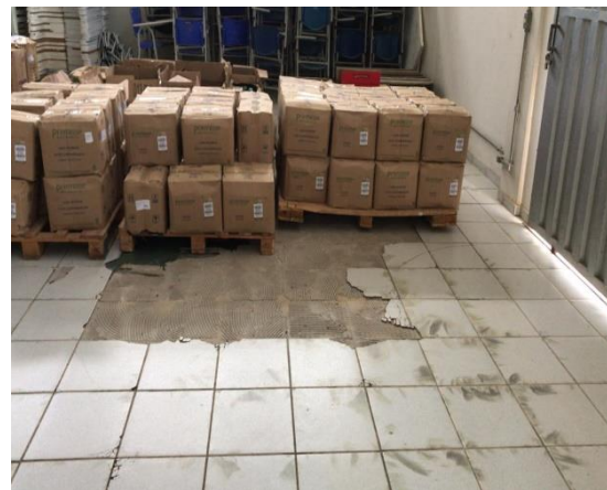
Figura 43: Condição dos revestimentos dos pisos do Almoarifado.
